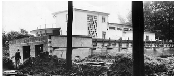
Rohbau der Kegelbahn im Jahre 1979
