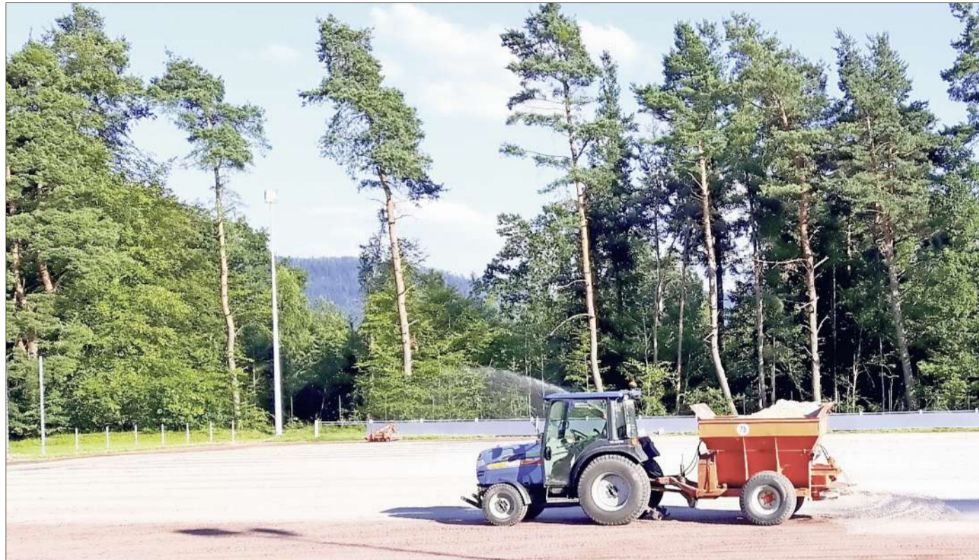
So fing der Umbau an: Verschiedene Substratmischungen werden auf den harten Untergrund aufgebracht. Fotos: Daniel Herm
