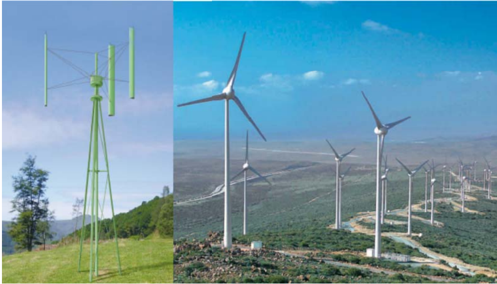
Abb. 9 Beispiele für vertikale und horizontale Windenergieanlagen (hier: Notos H40 und E44)
