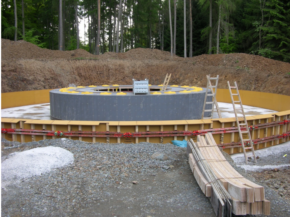
Abb. 4 Fundament einer WEA
